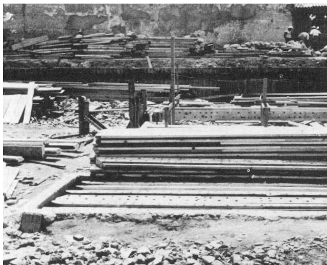
Fig. 4.4, Construcción de tablestacas de madera Wakefield , Zeevaert (1982)
