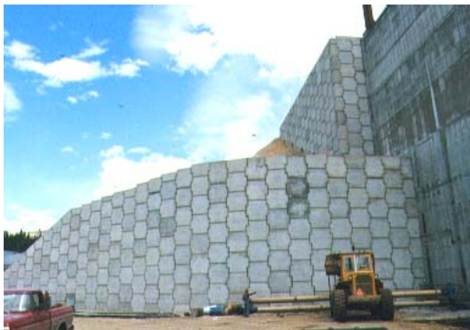
Fig. 6.13, Aplicaciones de tierra armada en obras industriales
