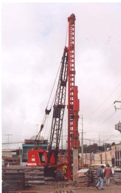
Fig 4.41, Hincado de tablestaca de concreto
