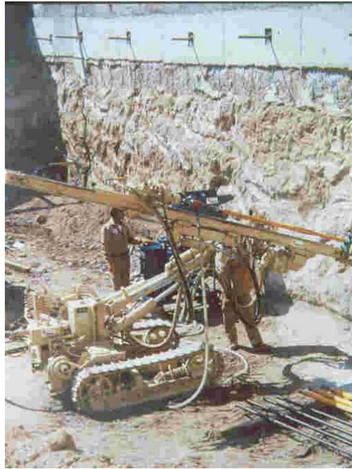
Fig. 4, Excavación anclada
