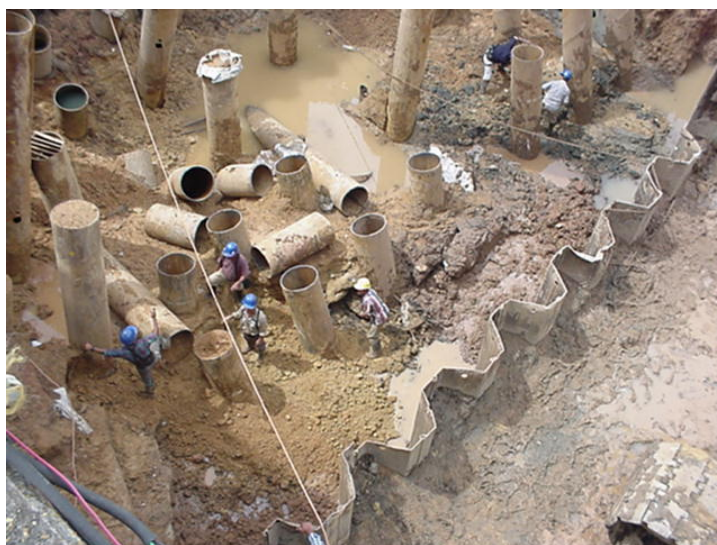
Fig. 1 Tablestaca metálica junto a pilotes tubulares
