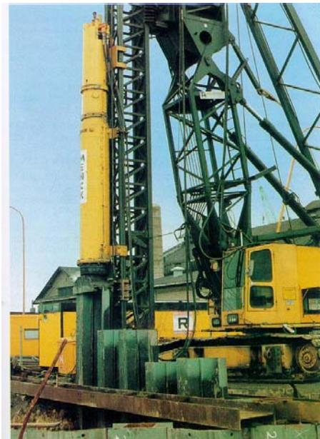
Fig. 4.17, Martillo hidráulico doble acción
