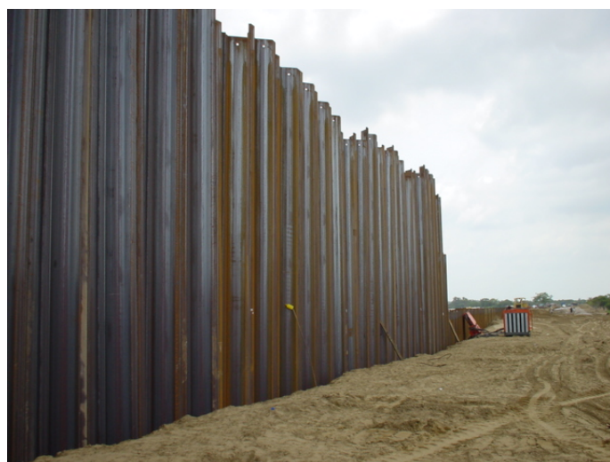
Fig.4.47, Secuencia de hincado
