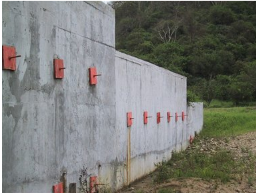
Fig. 3.126, Aspecto de los aleros anclados
