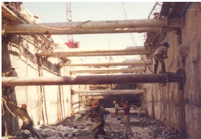
Fig. 3, Excavación en zanja para el metro de la ciudad de México, además con muros Milán
