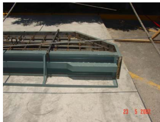
Fig. 4.8, Fabricación de tablestacas de concreto
