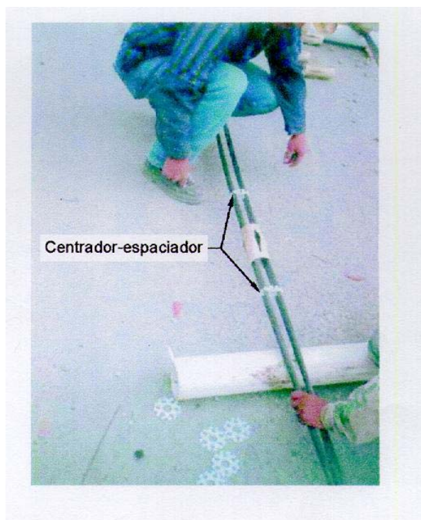
Fig. 5.17, Colocación de centradores y espaciadores
