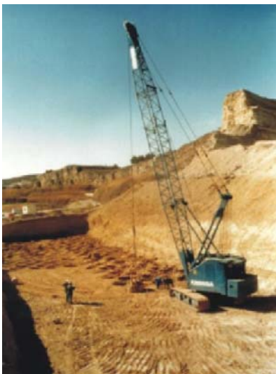
Fig. 6, Compactación dinámica
