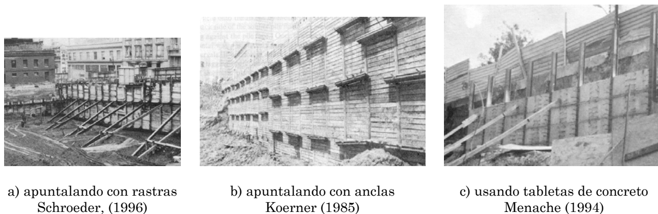
Fig 4.28, Ejemplos de uso de muros Berlín
