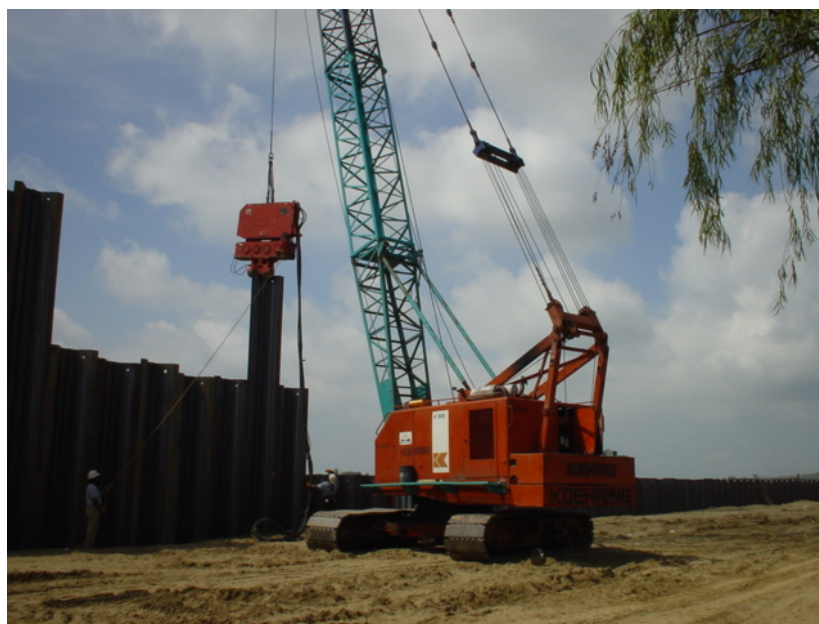
Fig. 4.46, Hincado de tablestacas
