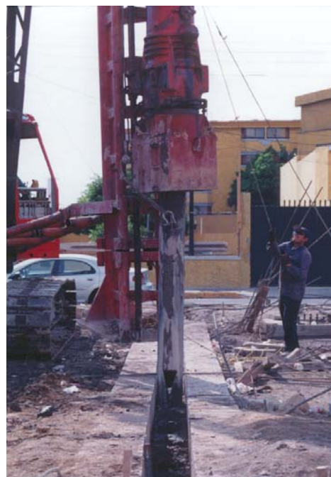
b) con brocal de concreto
