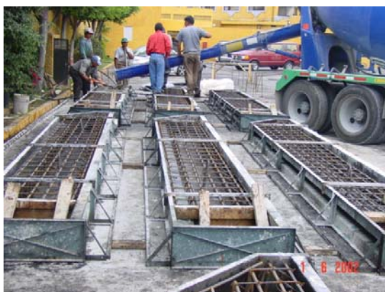
Fig. 4.8, Fabricación de tablestacas de concreto
