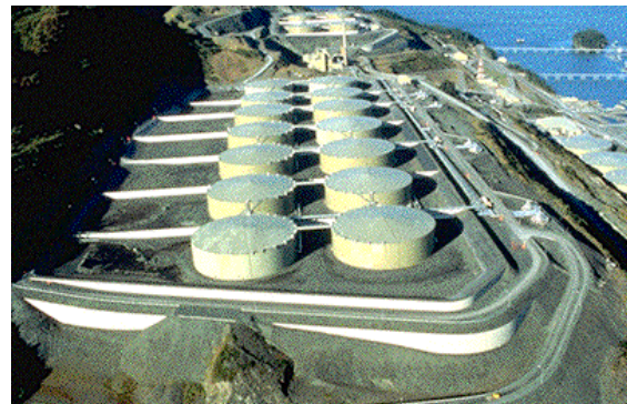
Fig. 6.13, Aplicaciones de tierra armada en obras industriales
