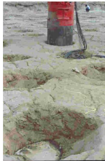
Fig. 7, Compactación en arena con ayuda de vibración
