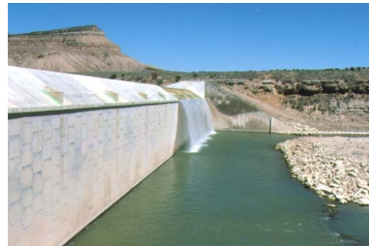
Fig. 6.12, Aplicaciones de tierra armada en obras marítimas y fluviales
