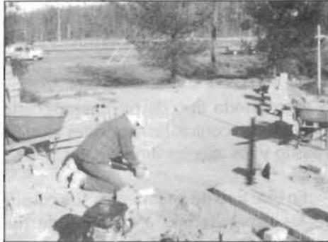
Fotografía 5.6 Volviendo a colocar los adoquines
