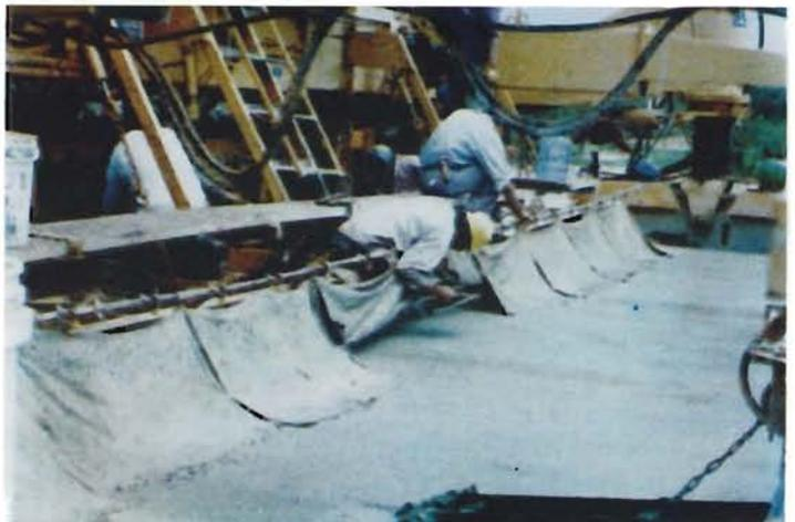
Fotografía 6.11 Inserción automática y manual de varillas de sujeción en juntas longitudinales, en la parte posterior de la pavimentadora.
