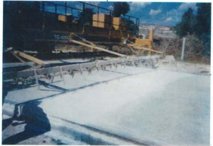
Fotografía 6.12 Ductos de aspersión de la membrana de curado, atrás del carro texturizador.
