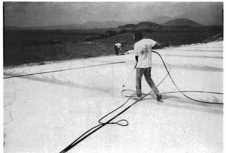
Fotografía 7.1 Aplicación de aire a presión para la limpieza de una caja receptora de sellante en una junta transversal.
