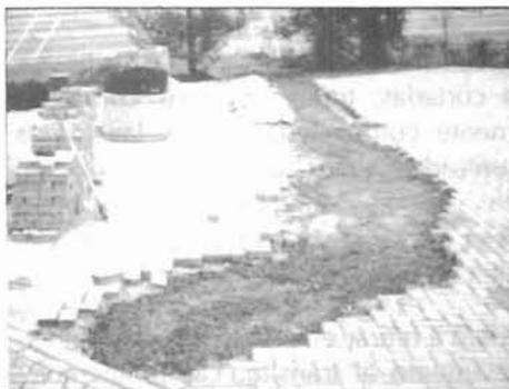
Fotografía 5.4 Base restituida y compactada.
