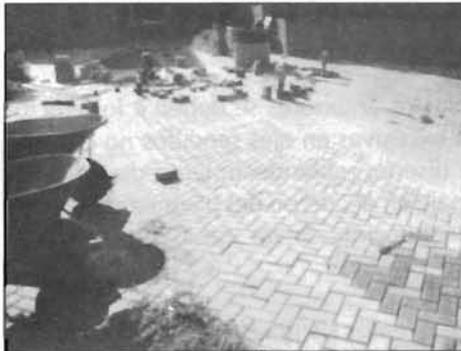
Fotografía 5.7 Colocación de hileras de adoquines coincidiendo con las existentes
