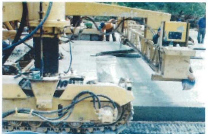
Fotografía 6.9 Aplanao mecánico en la parte posterior del equipo.
