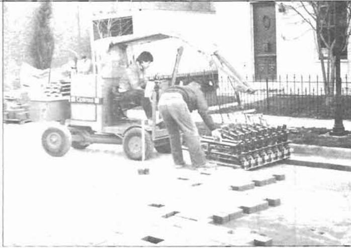
Fotografía 5.1 Equipo mecanizado para la colocación de adoquines.
