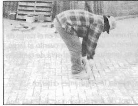
Fotografía 5.8 Ajustando las líneas de junta.
