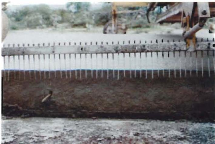
Fotografía 6.13 Bastidor con las cerdas metálicas de texturizado.
