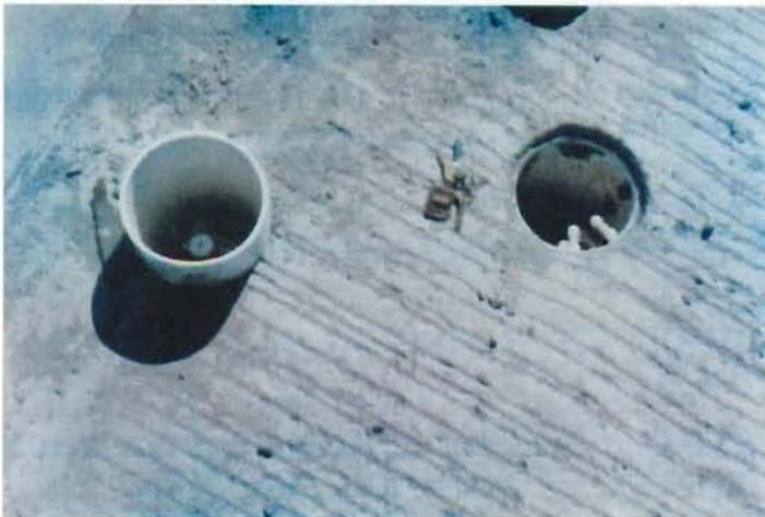
Fotografía 6.15 Distribución de ductos en el lecho de losa para determinar temperaturas.
