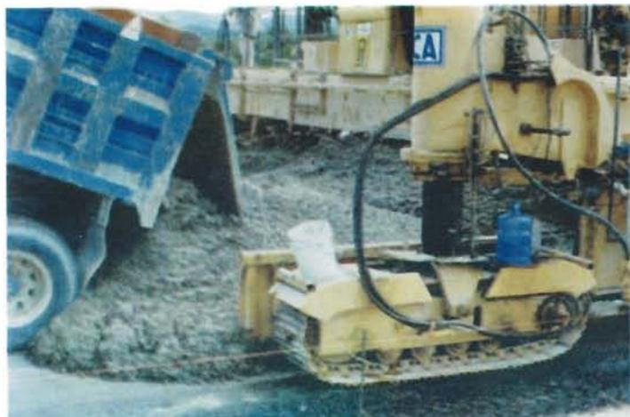
Fotografía 6.8 Colocación del concreto frente a la pavimentadora.
