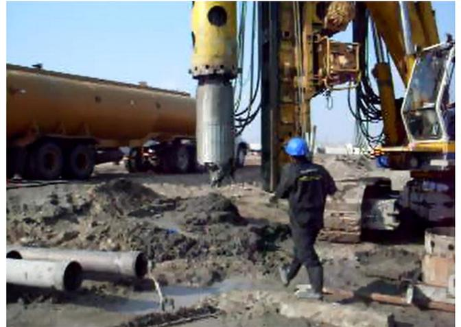
Foto 13. Excavación con cuchara y barreno, del suelo para pilote perforado.
