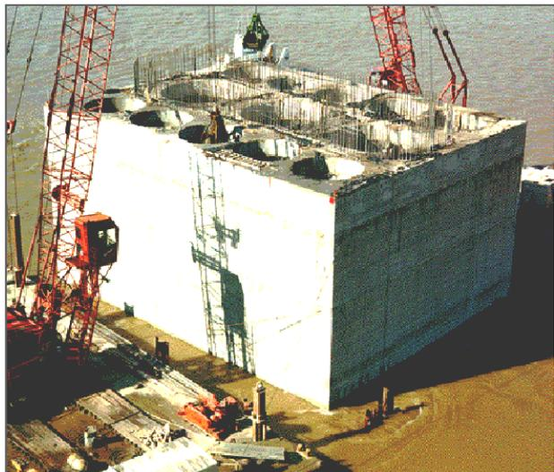
Fig. 34. Colocación de caisson (cimentación profunda) para pilar de puente.
