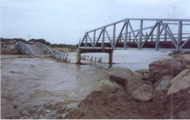
**Foto (8).** Puente Reque que falló debido a la socavación del suelo, durante el fenómeno de El Niño, por incremento de caudal; y mala ubicación respecto al suelo, y a las líneas de corriente del río.
