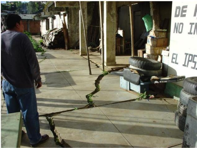
**Foto (2).** Efectos de expansibilidad en suelo del en el piso del hospital del IPSS de Chachapoyas.
