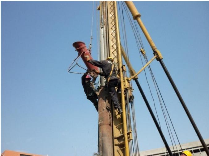
Foto 8. Vaciado del concreto a través del fuste del pilote.
