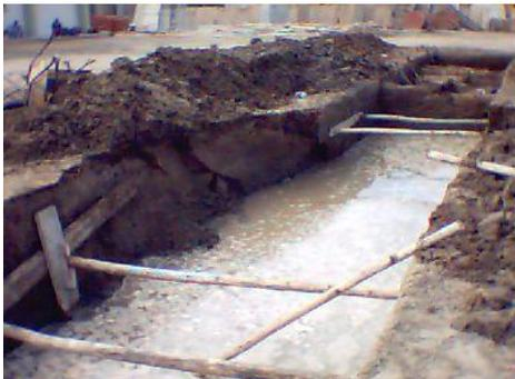
.Fig. 1. Desmoronamiento de un talud en suelo arenoso con poca cohesión en la ciudad universitaria de Lambayeque.
