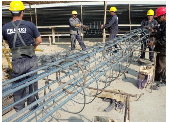
Foto 5. Fabricación de armadura de pilotes tipo Frankie
