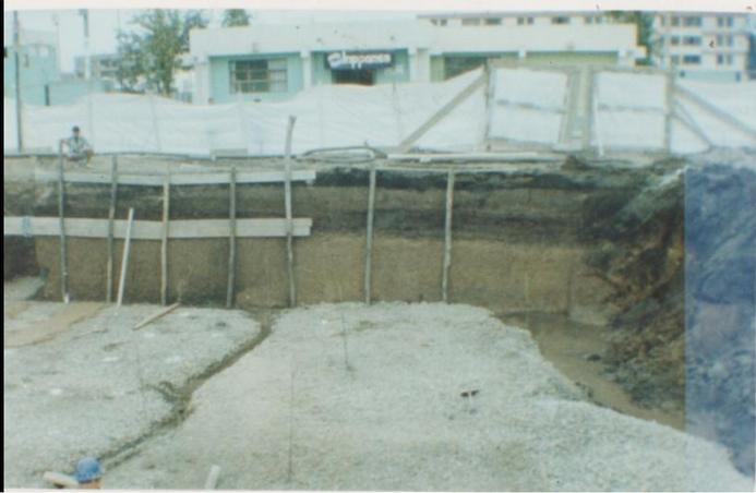
Fig. 29. Colocación de sistema de drenaje, antes y debajo de la cimentación. Proyecto: Sede Central de las Fiscalías del Distrito Judicial de Lambayeque. Chiclayo.
