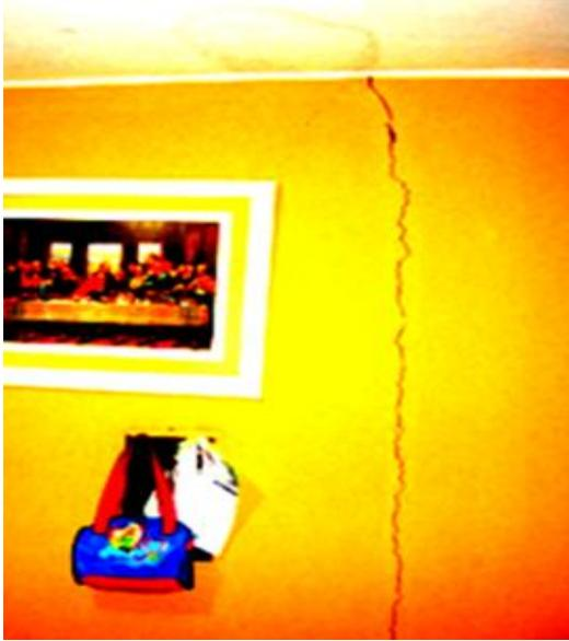
Foto (13). Falla de muro en casa de dos niveles por construcción adyacente de edificio de 7 niveles.
