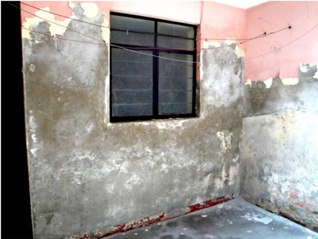
**Foto (9).** Efecto de las sales del suelo en paredes de edificación.
