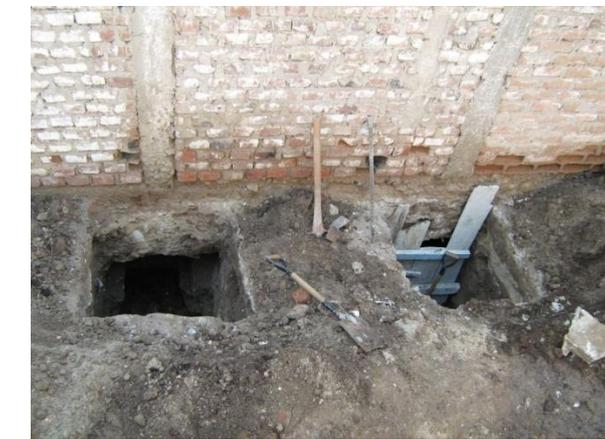
Fig. (24). Excavación alternada para hacer calzadura en la edificación vecina al proyecto nuevo.
