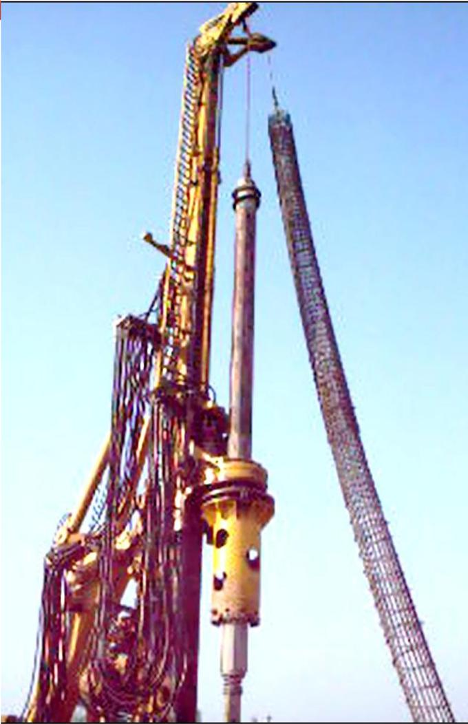
Foto 15. Izaje de armadura para colocación en el tubo o camisa.
