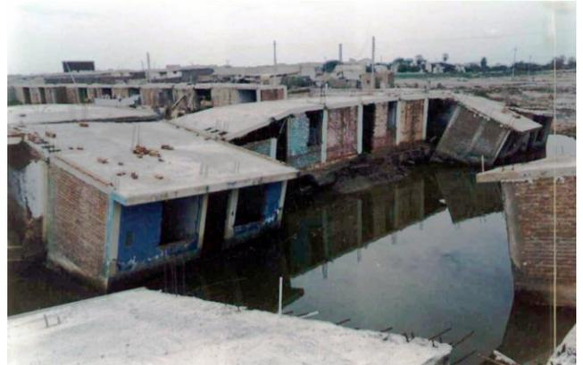
Fig. 6. Desastre por inundaciones, debido al fenómeno denominado "El Niño", en el conjunto habitacional Mocce, ubicado en la zona nor-oeste, de la ciudad de Lambayeque, Perú. Observar la concordancia con la zonificación de los mapas de inundaciones y de peligro síntesis.
