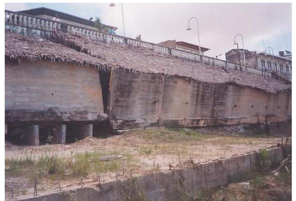
**Foto (6).** Falla en muro de contención en el Malecón Tarapacá en Iquitos.
