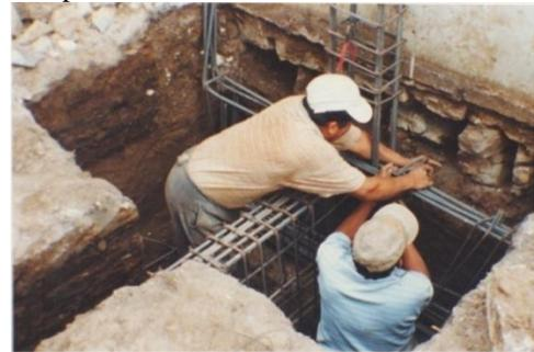
Fig. 27. Colocación de armadura de cimentación por tramos, por edificación de adobe vecina. Proyecto: Hostal Camgo en Chiclayo.
