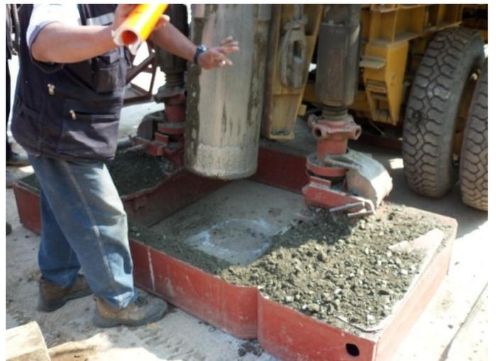
Foto 11. Detalle de la forma en que queda, la parte superior del pilote en el suelo.
