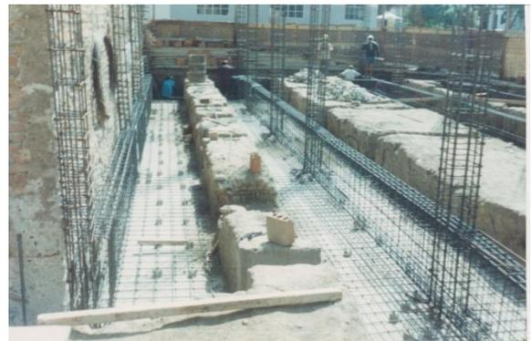
Fig. 13. Zapatas corridas en edificación Panadería Don Beny en Chiclayo.
