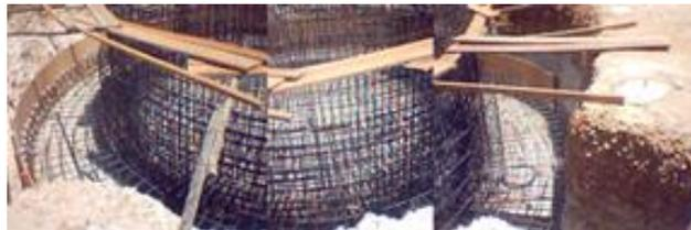
Fig. 37. Cimentación circular de tanque Elevado de Ciudad Eten, Lambayeque, Perú.
