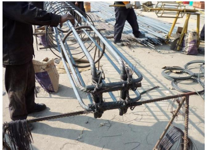
Foto 6. Reforzamiento de la parte inferior de la armadura.
