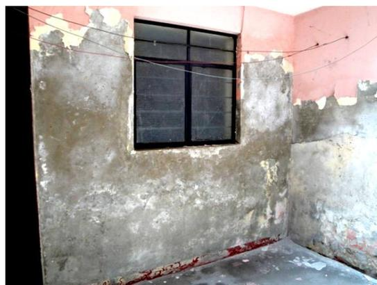
Fig. (5). Efecto de las sales del suelo en paredes de edificación en el puerto del Callao, Lima. Perú.
