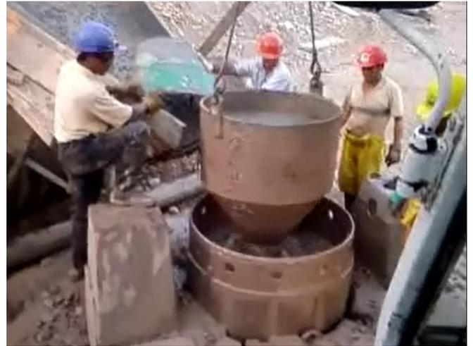
Foto 17. Llenado de concreto con embudo.
