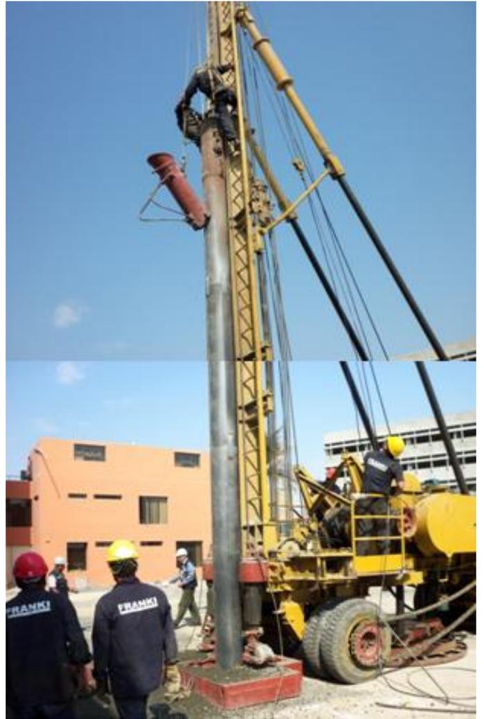
Foto 10. Vista compuesta del equipo de instalación del pilote.
