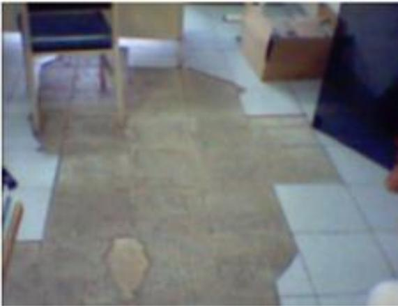
**Foto 2.** Falla del cerámico del aligerado del primer piso de la fiscalía de Lambayeque, por asentamiento del suelo
