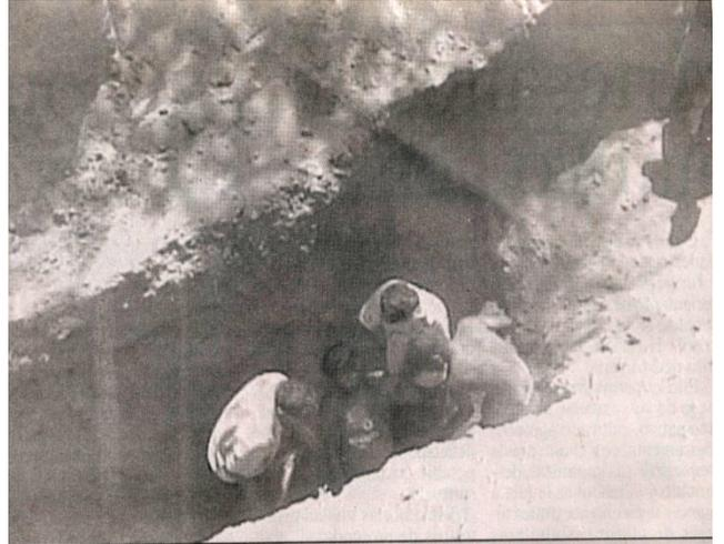
Foto (15). Dos obreros murieron por derrumbe de excavación de zanja de desagüe, el 26 de Setiembre del 2006, en Cayalti. El suelo era arenoso y la excavación era de 3m de profundidad. Instantes en que son sacados.
