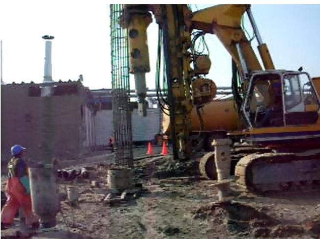
Foto 16. Colocación de armadura dentro de la camisa.
