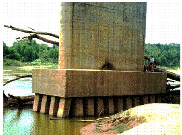
Fig. 33. Socavación local en pilar de puente con pilotes.
