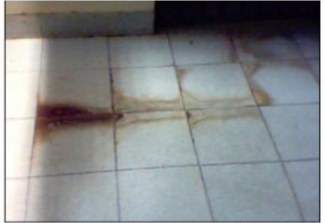
Daño en el sótano de edificación de obra pública en Lambayeque, se aprecian los daños por asentamiento y por filtración de agua freática.
