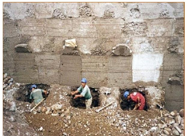
Fig. 22. Calzadura según el Ing. G. Delgado Contreras.
