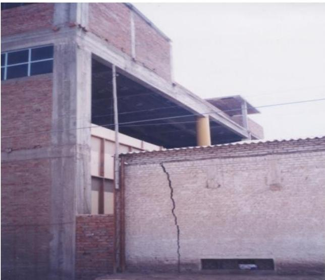
Fig. (1). Daños en edificación por excavación de 4 m para sótano.
