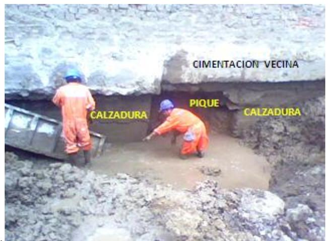
Fig. (11). Ejecución de calzadura en obra de Chiclayo. Cuando hay agua, hay que usar bomba. La excavación se hizo con retroexcavadora
