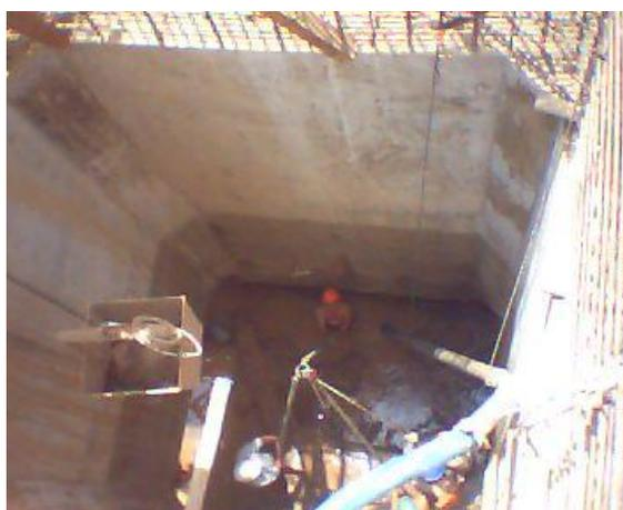
Fig. 35. Fondo del caisson del Puente Pítipo, Ferreñafe, Perú, ejecutándose el ensayo de SPT.
