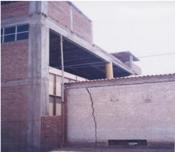
Fig. 1. Daños en edificación antigua, debido a excavación de sótano, de la edificación nueva de la izquierda. Obra en Chiclayo, Perú.
