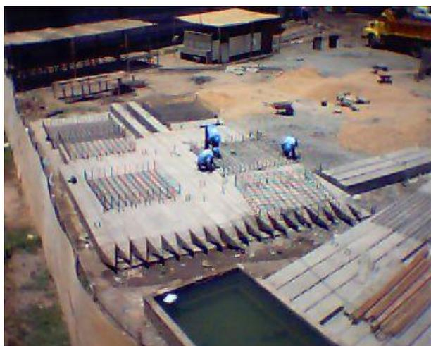
Fig. 36. Grupo de pilotes pre-fabricados, para la cimentación del Poder Judicial de Chiclayo. Perú.
