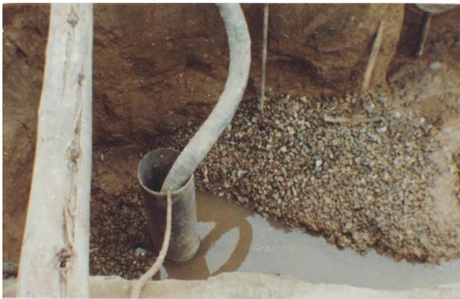
Fig. 30. Detalle del sistema de drenaje.
