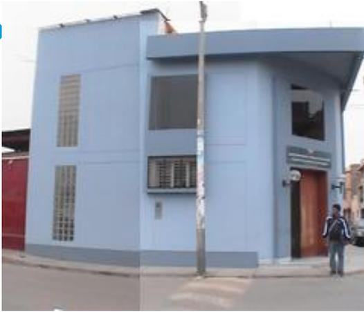
**Foto 1.** Sede de la fiscalía en la ciudad de Lambayeque, en donde se presentan fallas por asentamientos. La capacidad portante de diseño fue calculada erróneamente en 4 kg/cm<sup>2</sup> (siendo de 0.70 kg/cm<sup>2</sup>). Las zapatas para 5 niveles (incluido sótano), se diseñaron de 1.50m x 1.50 m .
