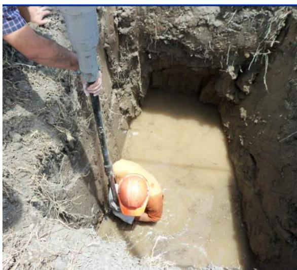
Fig. (4). El nivel del manto acuoso debe constar en el informe, para evitar las filtraciones en la edificación.
