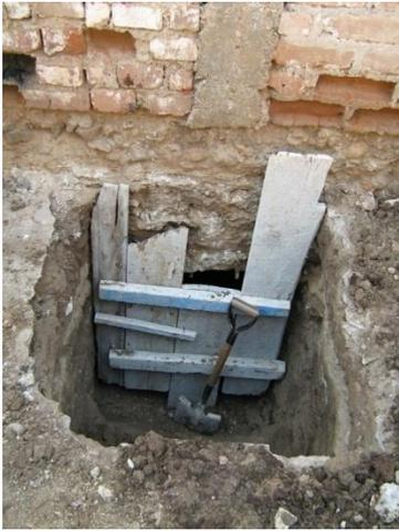
Fig. 23. .Detalle de ejecución de calzadura, previo a la excavación de cimentaciones.
