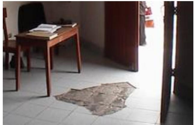
Desprendimiento del cerámico de losa aligerada En construcción de Lambayeque, debido al asentamiento del suelo.
