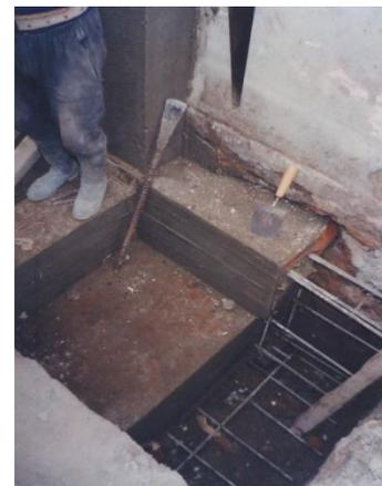
Fig. 28. Concreto vaciado en cimentación por tramos, por edificación de adobe vecina. Proyecto: Hostal Camgo en Chiclayo.
