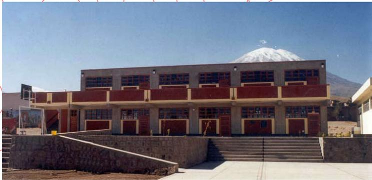
**Figura 6.10** Edificio educativo en el sur del Perú sin daño luego del terremoto de Atico en el 2001,  $M_w= 8.4$
