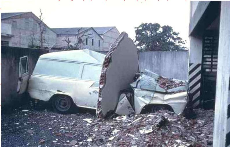
**Figura 7.39 Auto partido en dos por muro colapsado.**
