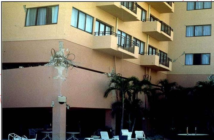
*Figura 7.32 Colapso de segundo piso debido a los altos alfeizares que producen el fenómeno de columna corta, terremoto de Guam 1993.*
