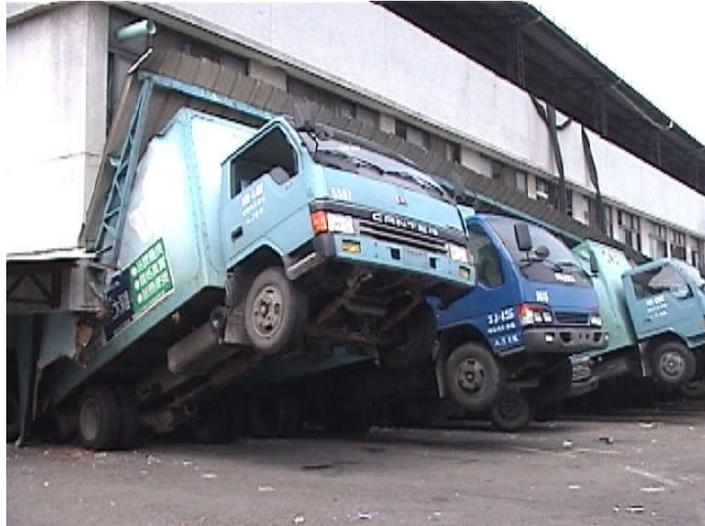
*Figura 7.40 estacionamiento de camiones colapsado*
