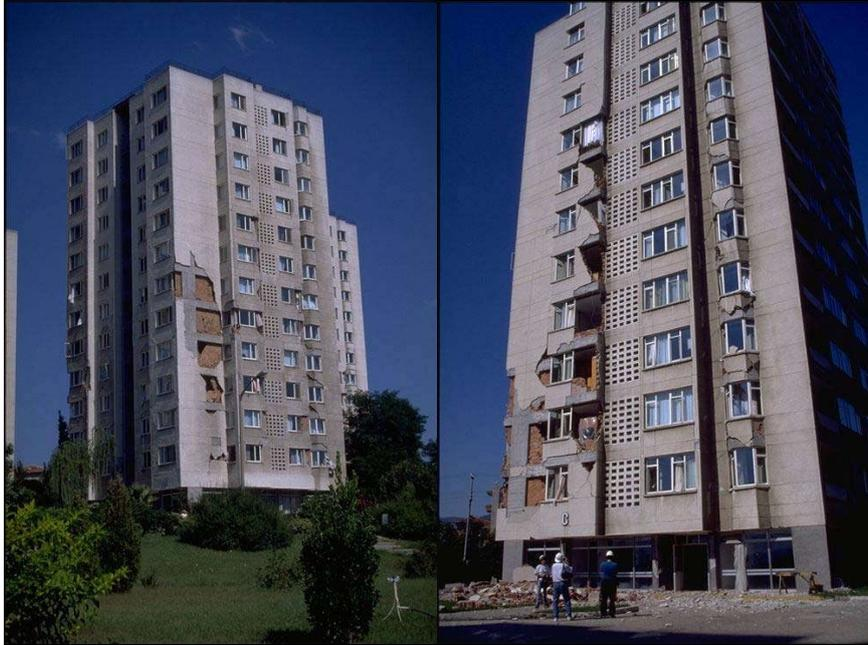
**Figura 7.38 Muros Daño en mampostería en edificio de departamentos, muros de tabaquería dañados. Izmir 1999, Turquía.**
