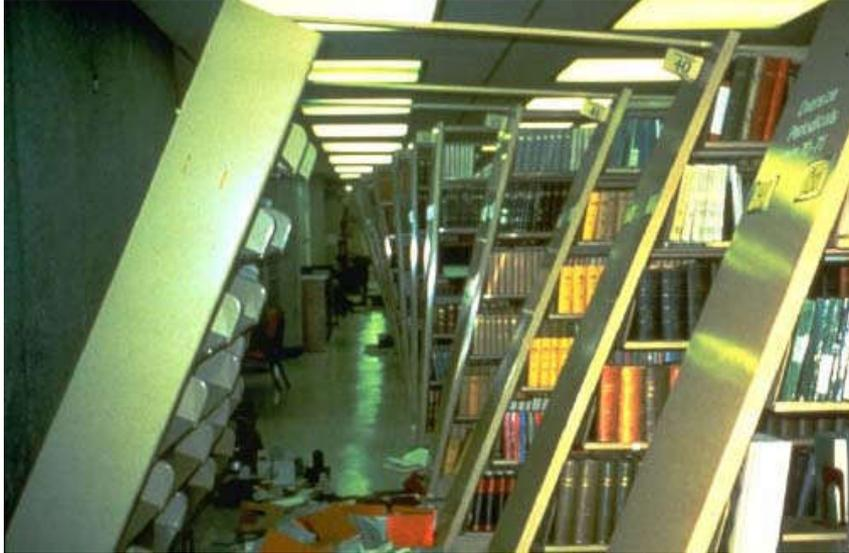
**Figura 7.35** Interior de la biblioteca de la Universidad Estatal de California, terremoto de 1987 Whittier Narrows. Los estantes se inclinaron transversal y longitudinalmente, la gran masa que soportan requiere manejo ingenieril en los apoyos.
