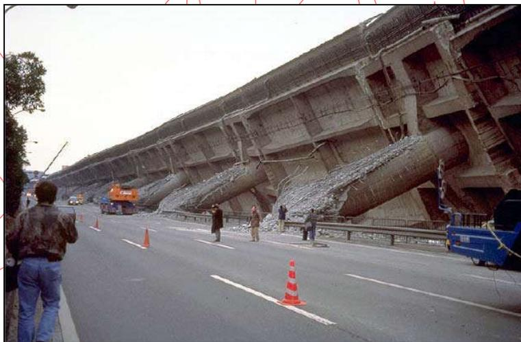
**Figura 4.1** Colapso de una autopista elevada en el terremoto de Kobe, Japón, 1995
