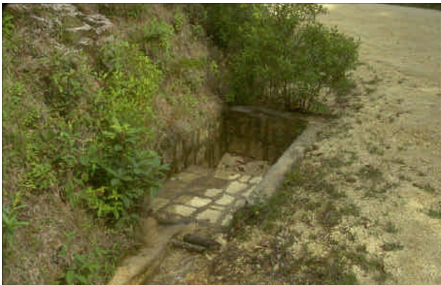
Foto 7.3 Use estructuras de toma hechas de mampostería, concreto o metal para controlar el agua en la cuneta y encauzarla hacia el tubo de drenaje transversal y evitar la socavación de la cuneta.
