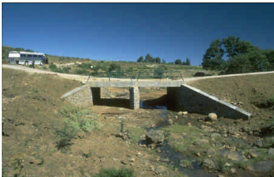
Foto 8.3 Instale alcantarillas de mampostería, de cajones de concreto o de metal, con un tamaño (capacidad) lo suficientemente grande para desalojar con seguridad la avenida de diseño anticipada (típicamente para un periodo de recurrencia de 20 a 50 años), con base en un análisis hidrológico. Use muros de cabeza o de alero siempre que sea posible.
