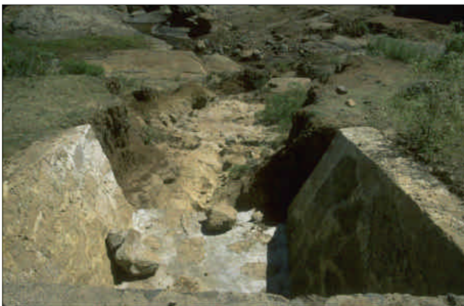
Foto 7.4 Agregue protección a la salida del drenaje y/o disipadores de energía, para evitar la erosión y formación de barranquillas aguas abajo de la estructura protegida.
