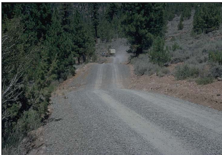
Foto 7.1 Diseñe los caminos para que eliminen el agua rápidamente de la superficie de rodamiento y minimicen las concentraciones de agua, mediante el uso de peralte hacia afuera, hacia adentro o coronamientos y agregue pendientes ondulantes.
