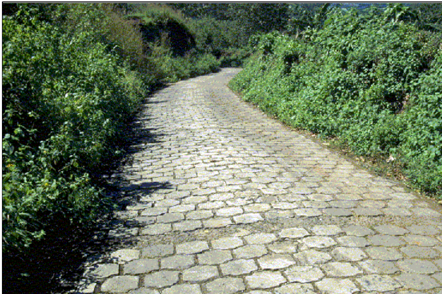
Foto 12.7 Los bloques de concreto (Adoquines) o empedrados ofrecen una alternativa intermedia a las superficies de rodamiento de agregados o de pavimento. Estos materiales requieren de mucha mano de obra para colocarlos y darles mantenimiento, pero resultan muy redituables en cuanto a costos, en muchas regiones.
