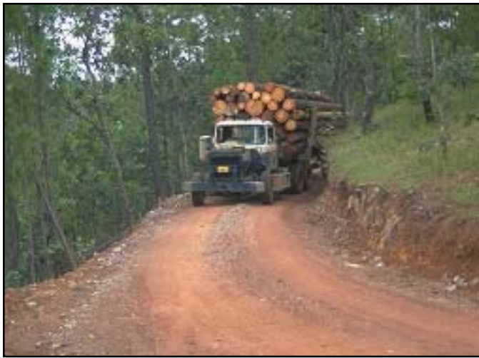
Foto 4.5 Camino estable para acarreo de troncos con superficie de agregados. Use materiales para recubrimiento de caminos tan frecuentemente como sea posible, para disminuir la erosión, mejorar el soporte estructural de la base del camino y el confort del conductor.
