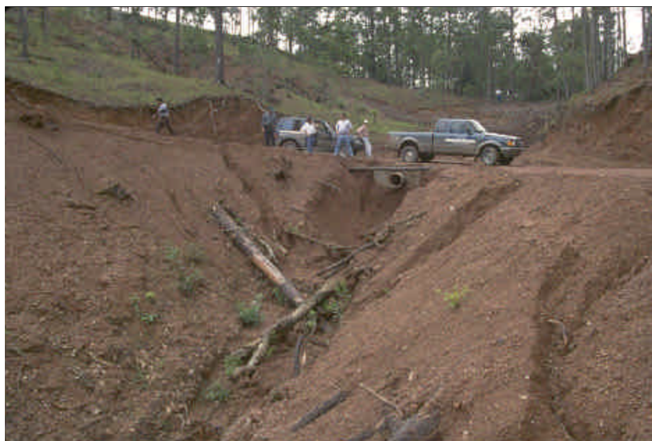
Foto 8.9 Evite colocar bocas de salidad de alcantarillas en la parte media de una talud de terraplén. Use alcantarillas lo suficientemente largas para sobresalir del pie del talud del terraplén, o use estructuras de muros de cabeza para retener el material de relleno y minimizar la longitud del tubo.
