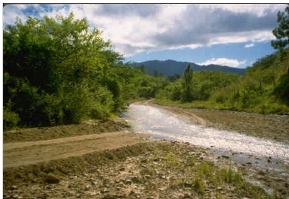
Foto 7.8 Evite cruces del drenaje natural que sean anchos y que no sean perpendiculares al drenaje. ¡Aléjese del arroyo! Este canal ancho es un buen sitio para un vado con alcantarillas.
