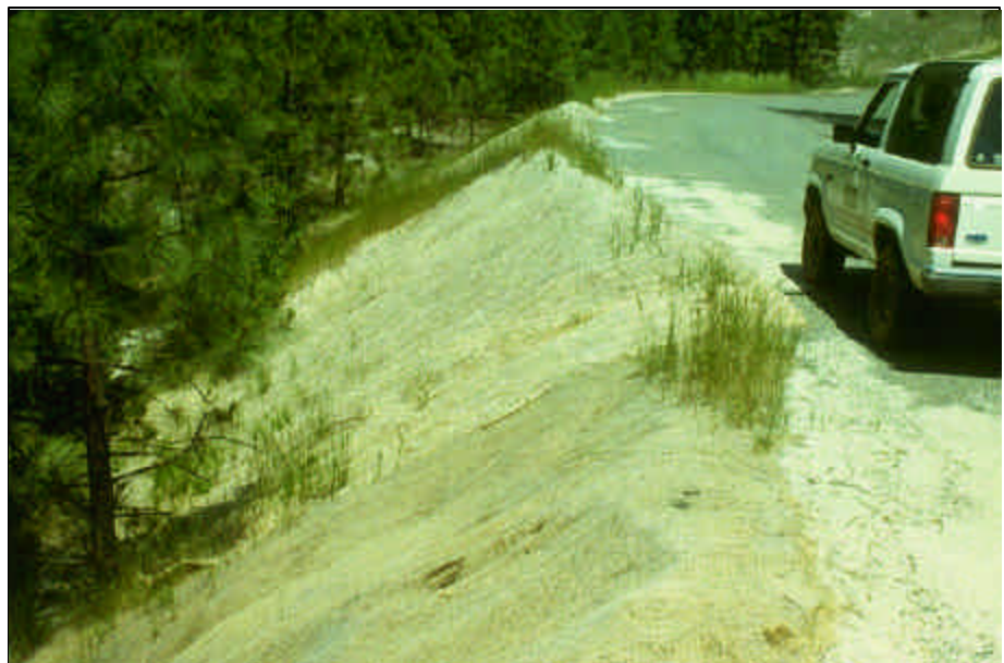
Foto 13.3 Cubra los taludes de terraplenes, sitios de trabajo y otras áreas expuestas del suelo con paja, redes roca u otro tipo de materiales, a fin de proteger el terreno y promover el crecimiento de la vegetación.
