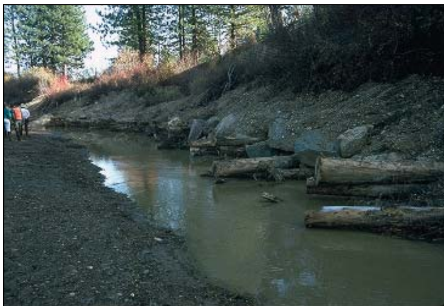
Foto 6.3 Un fajo de raíces, troncos y márgenes del arroyo protegidas con enrocamiento, se usan como protección contra la socavación. Los troncos y vegetación pueden brindar una alternativa atractiva al enrocamiento en zonas del arroyo con velocidades relativamente bajas.
