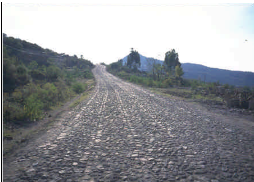
Foto 1.4 Camino bien diseñado de “impacto mínimo” que tiene una especificación adecuada para su uso, así como una superficie de rodamiento (empedrado) estabilizada.
