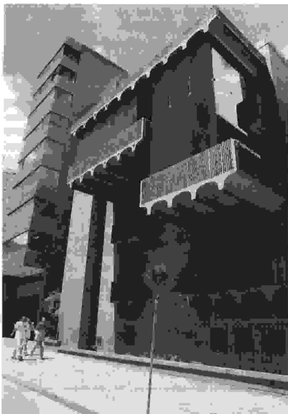
FIGURA 18.12 Edificio de oficinas en Bogotá, Colombia, con losa de viguetas en voladizo.
