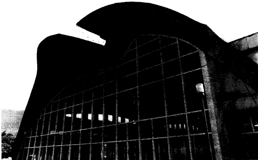
FIGURA 1.7 Cascarón esférico en Medellín, Colombia. Las superficies de borde en voladizo proporcionan rigidez al domo lateral.
