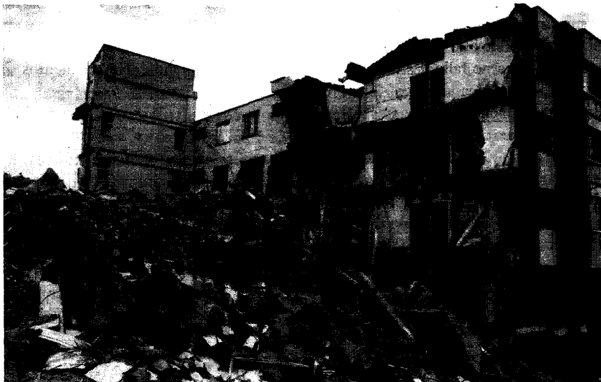
FIGURA 20.5 Daño a edificación como resultado del sismo de la ciudad de Armenia, Colombia.
