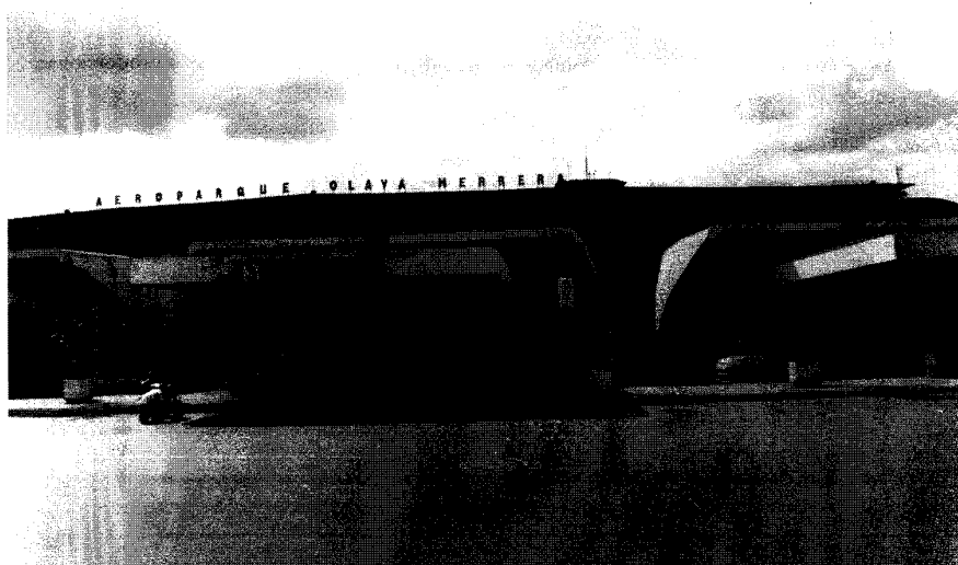
FIGURA 1.6 Cubierta de cascarones cilíndricos que proporciona un espacio interior libre de columnas.
