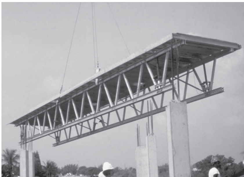
El sistema de tablero armadura para la formación de la cubierta. (Cortesía de Symons Corporation.)
