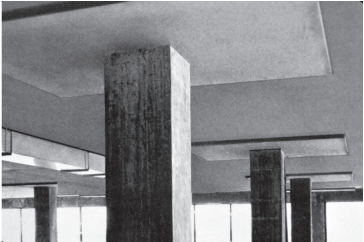
Losa plana con ábacos y sin capiteles en las columnas. (Cortesía de Portland Cement Association.)
