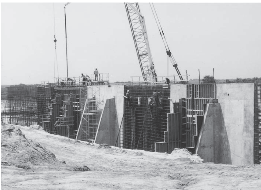
Muros de cimentación de treinta y dos pies de alto para el MCI Mid-Continent Data Center en Omaha, Nebraska. (Cortesía de Economy Forms Corporation.)
