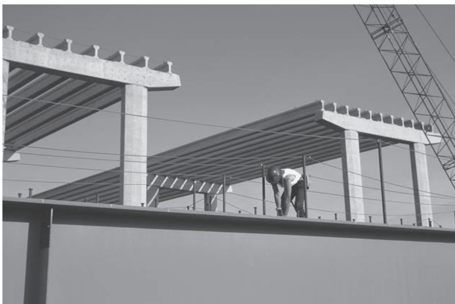
Construcción de un puente. (PhotoDisc, Inc./Getty Images.)
