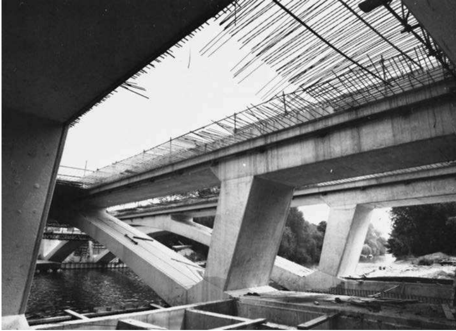
Puente Runnymede de concreto presforzado sobre el Río Támesis, cerca de Egham, Surey, Inglaterra. (Colección CC&A, cortesía de The Concrete Society.)
