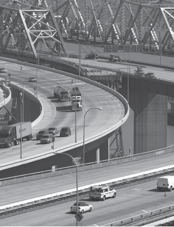
Puente de autopista sujeto a cargas en movimiento
