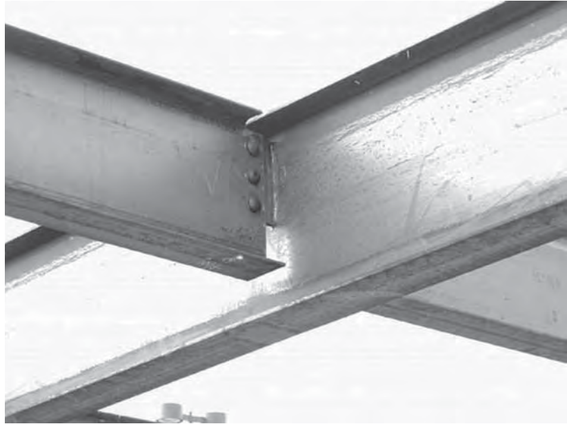
(b) Conexión a cortante viga a viga
