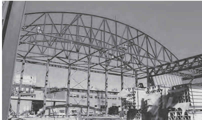
FIG. 4.1 Armaduras de techo de la Escuela Secundaria del Ciruelo (Plum High Schol). Grandes armaduras de arco y armaduras de soporte para el gimnasio)
