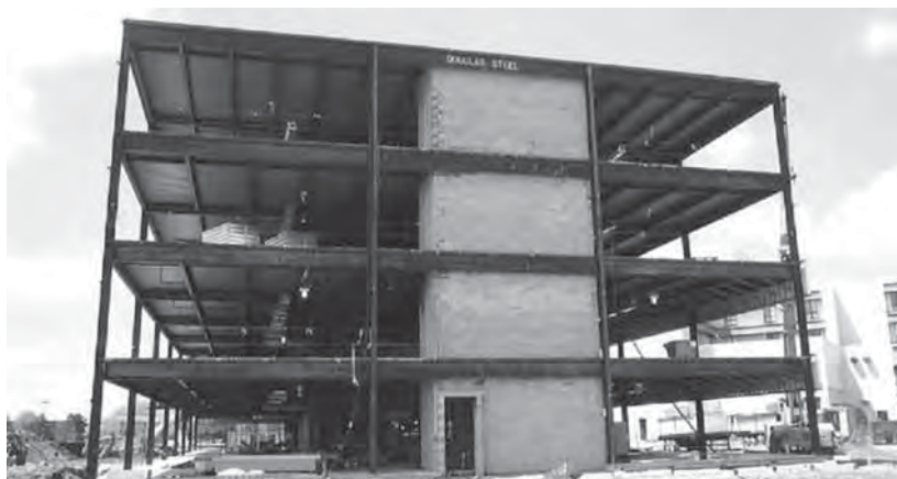
FIG. 2.3 Este edificio con muros de mampostería se emplea para los núcleos de elevadores y escaleras para resistir las cargas laterales debidas al viento y a sismos.
