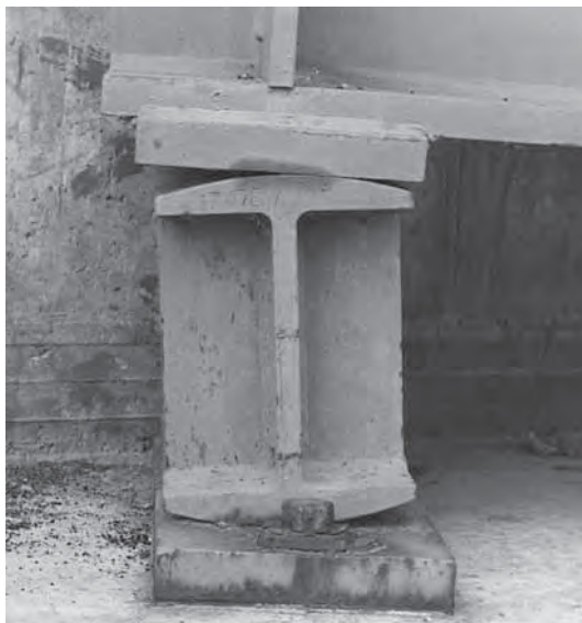
FIG. 3.5 Apoyo basculante o de péndulo Maureen M. Kassimali
