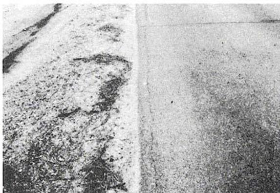
**Figura B-7.a.** Agrietamiento de Borde Baja-severidad.
