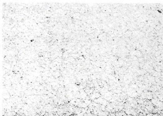
**Figura C-16.a.** Escamadura / Agrietamiento de Mapa / Dilapidado Baja-severidad.
