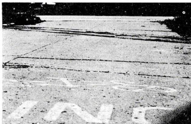
**Figura C-15.b.** Cruce de Ferrocarril Media-severidad.
