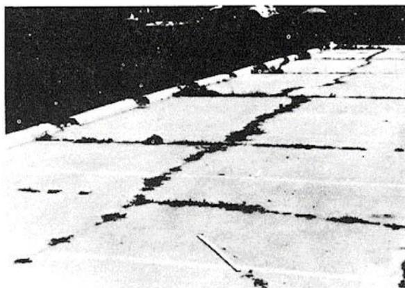
**Figura C-3.b.** Losa Dividida Media-severidad.
