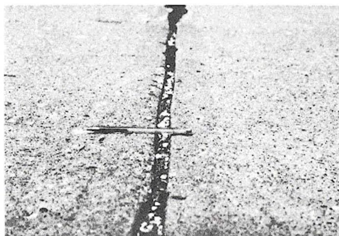
**Figura C-6.c.** Daño del Sello de Junta Alta-severidad.
