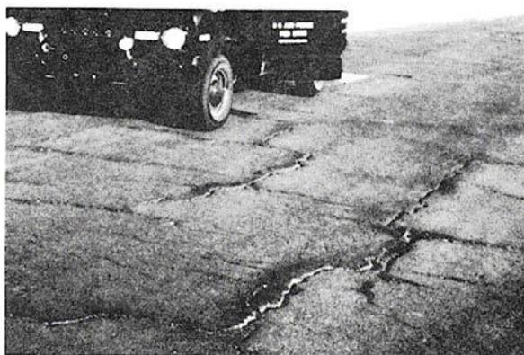
**Figura B-3.c.** Agrietamiento en bloque Alta-severidad.
