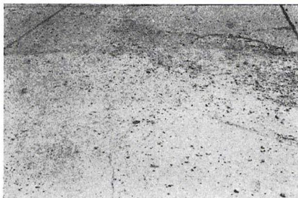
**Figura C-4.c.** Agrietamiento (“D”) de Durabilidad Alta-severidad.
