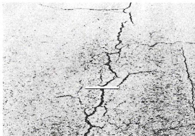
**Figura B-10.b.** Agrietamiento Longitudinal y transversal Media-severidad.
