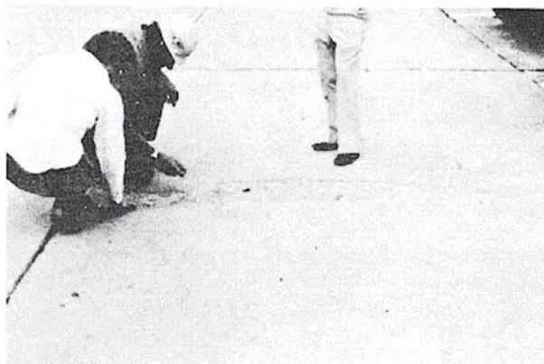
**Figura C-4.b.** Agrietamiento (“D”) de Durabilidad Media-severidad.
