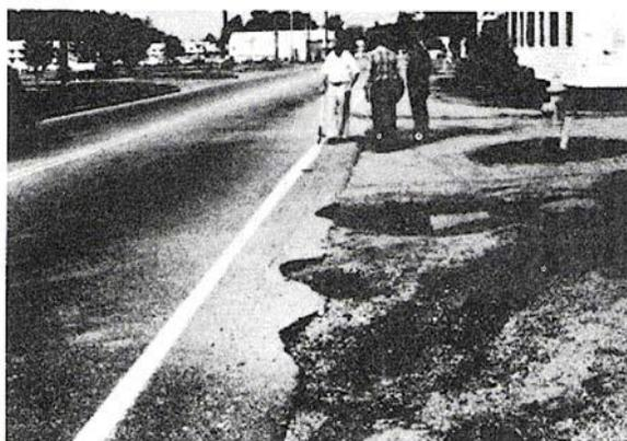
**Figura B-7.c.** Agrietamiento de Borde Alta-severidad.
