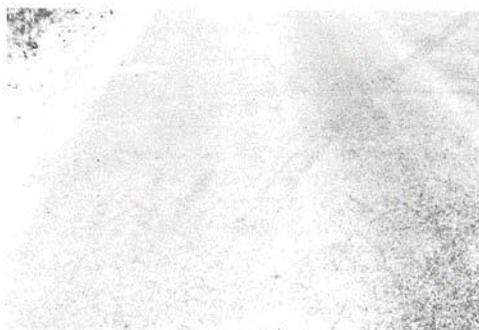
**Figura B-2.a.** Exudación o Sangrado Baja-severidad.
