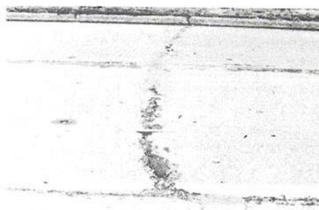
**Figura C-8.c.** Agrietamiento Lineal Alta-severidad.
