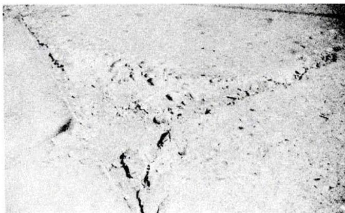
**Figura C-18.c.** Escamadura de Esquina Alta-severidad.
