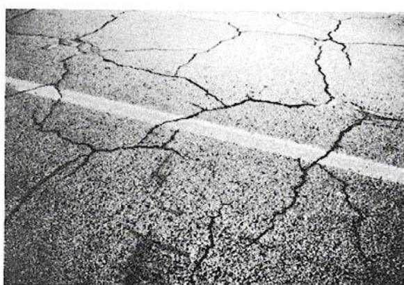
**Figura B-3.b.** Agrietamiento en bloque Media-severidad.
