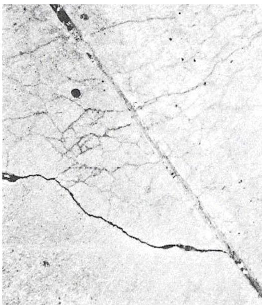
**Figura C-2.a.** Ruptura de Esquina Baja-severidad.
