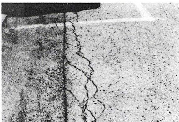
**Figura B-7.b.** Agrietamiento de Borde Media-severidad.
