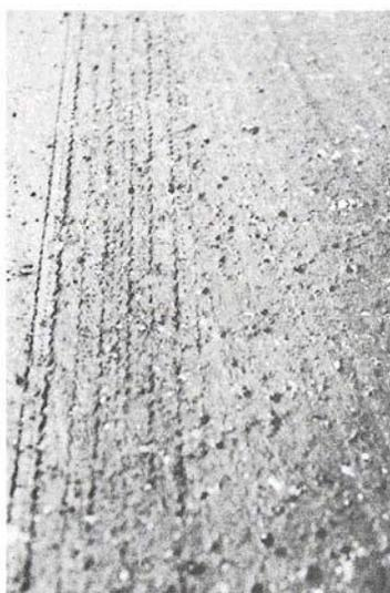
**Figura B-2.c.** Exudación o Sangrado Alta-severidad.
