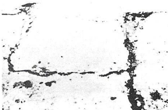
**Figura C-9.c.** Grande Parchado y Corte de Utilidad Alta-severidad.
