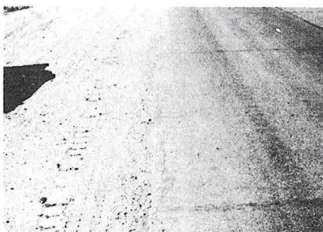
**Figura B-8.a.** Agrietamiento Reflejo de Juntas Baja-severidad.
