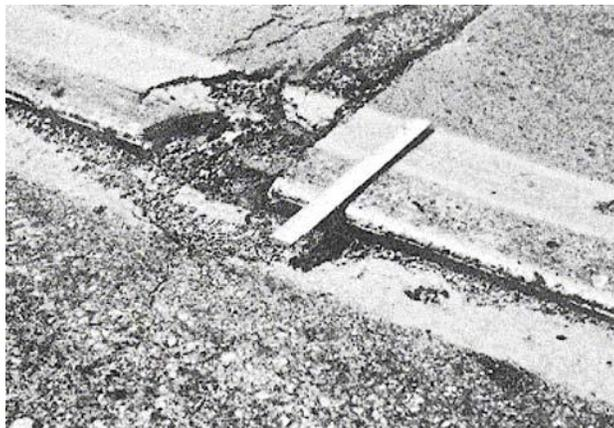
**Figura C-7.a.** Caída Externa de Vía / Hombarrera Baja-severidad.
