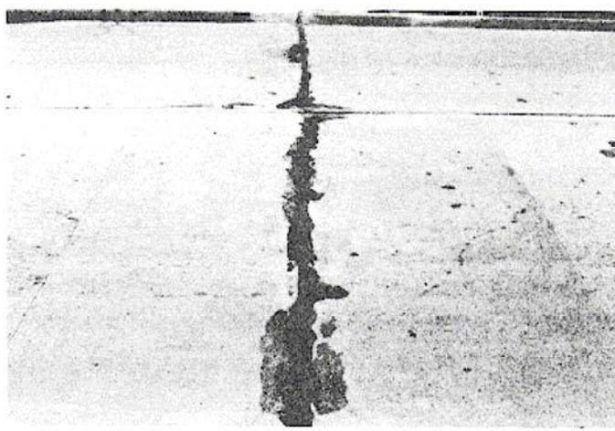
**Figura C-6.a.** Daño del Sello de Junta Baja-severidad.
