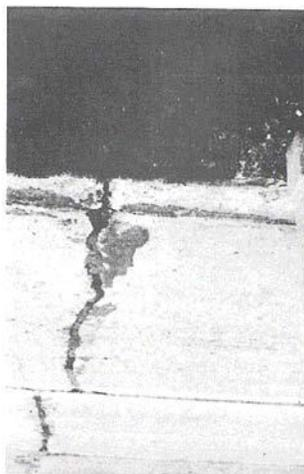
**Figura C-8.b.** Agrietamiento Lineal Media-severidad.
