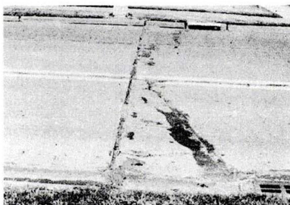
**Figura C-14.b.** Punzonamiento Media-severidad.
