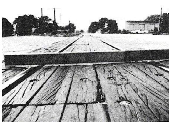
**Figura B-14.a.** Cruce de Ferrocarril Baja-severidad.
