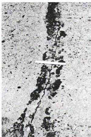
**Figura C-8.a.** Agrietamiento Lineal Baja-severidad.
