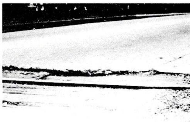
**Figura C-15.c.** Cruce de Ferrocarril Alta-severidad.
